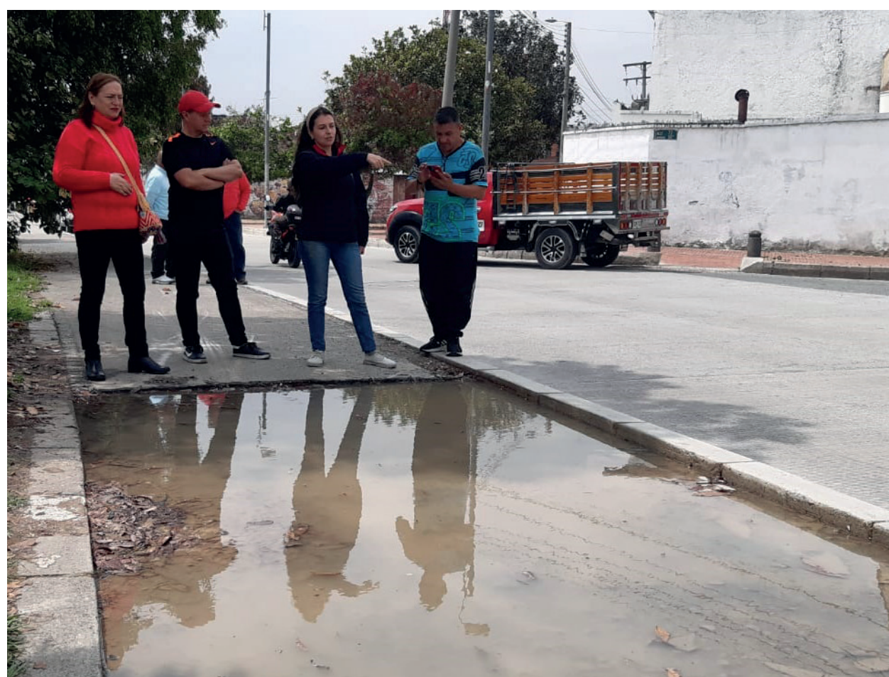
La Contraloría de Bogotá, D.C. visitó el barrio 12 de Octubre para verificar las denuncias ciudadanas sobre el deterioro de la malla vial, entre otros temas.
